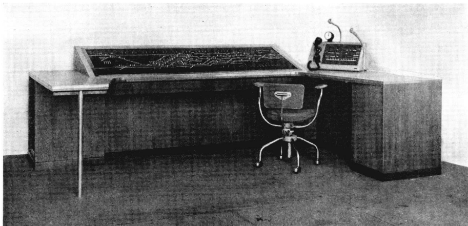
Fig.9. Det nye centralapparat og teleanlæg. Den automatiske togjournal skal placeres til højre i billedet.
